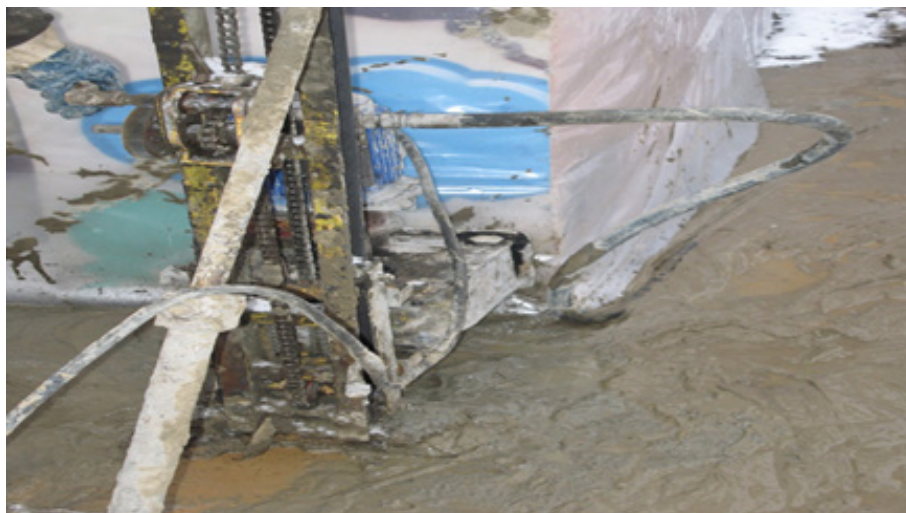
Рис. 1. Работы по усилению здания грунтоцементными сваями
